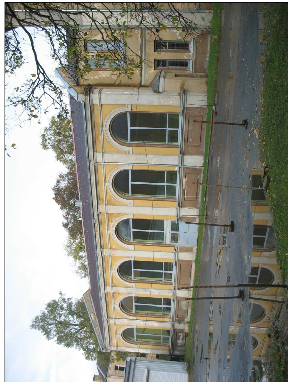
Foto Nr. 1 Sporta zāles kopskats no pagalma puses. Ekspluatācijas laikā jumta kore ir ievērojami sēdusies.
