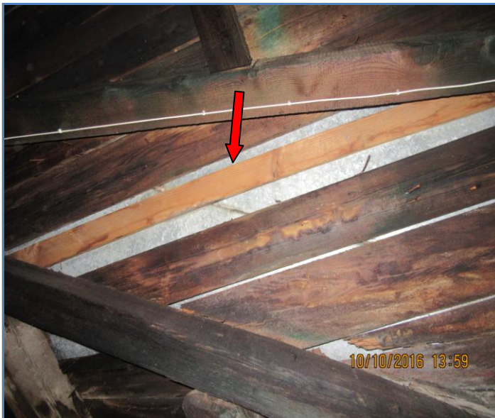
19.att.Bojātā jumta dēļu klāja pagaidu pastiprinājums.
