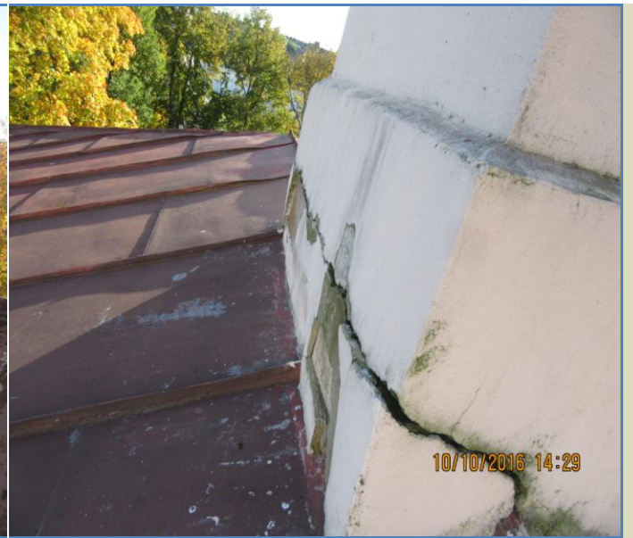
68.att. Dūmkanāla salaidums ar jumta segumu.
