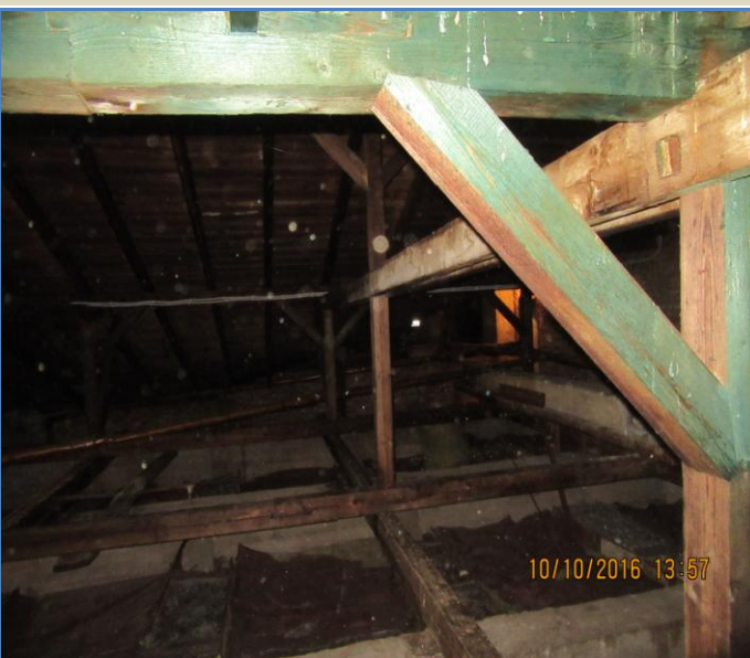
12.att. Jumta krēsla konstrukcija.
