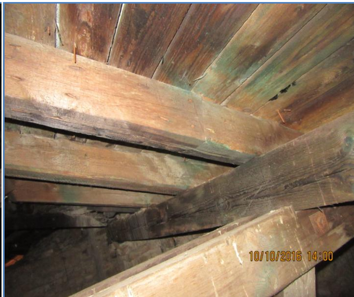
14.att.Jumta nesošās konstrukcijas krēsls.
