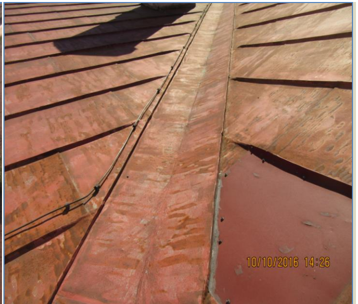
56.att.Jumta iekšējā satece ar skārda ielāpu.
