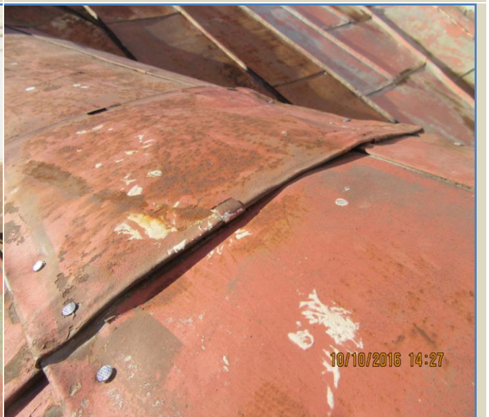
58.att.Pienāglotais skārda segums virs gaismas lūkām.
