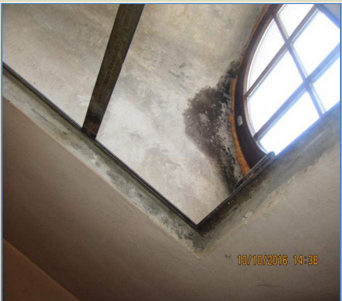
69.att. Kāpņu telpas gaismas logs.
