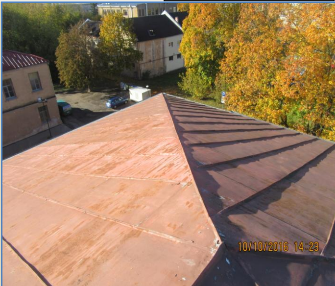
45.att.Jumta skārda segums
