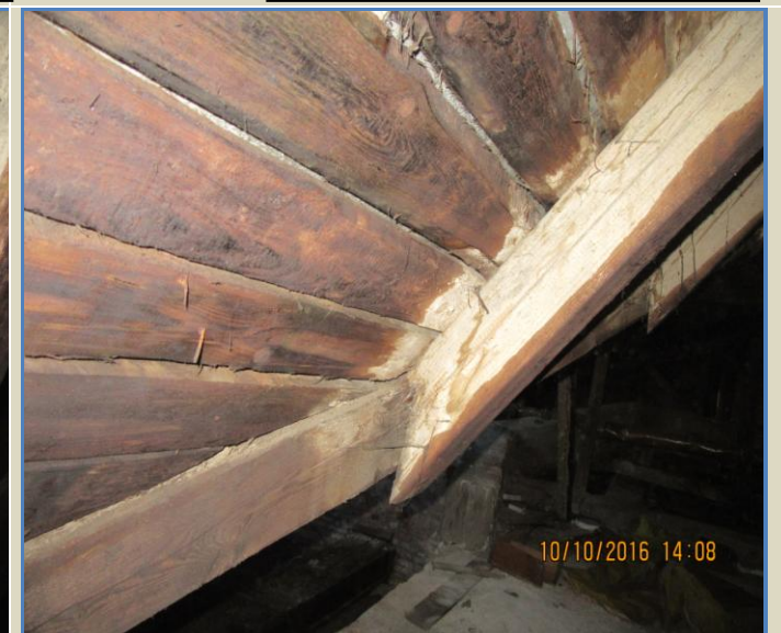
30.att. Vidējā sateces spāre bez konstruktīva balsta.
