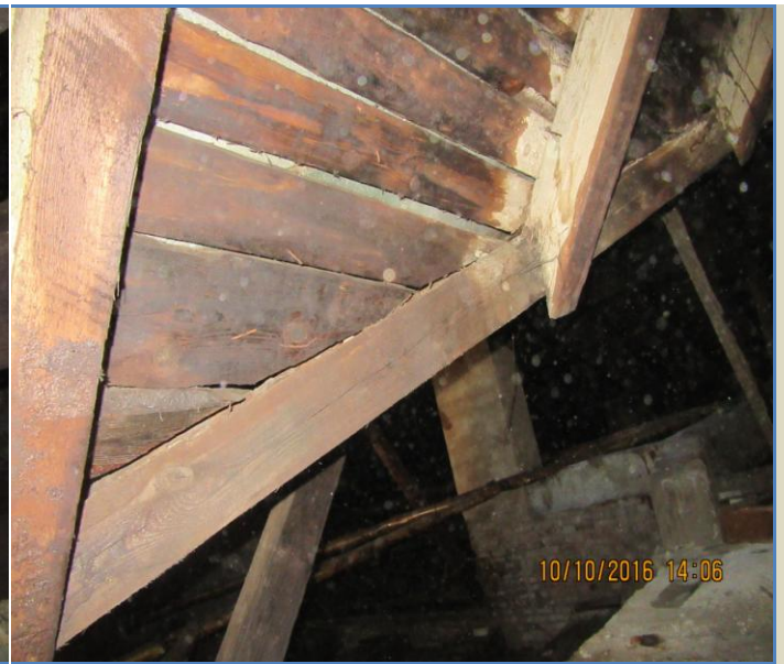
26.att. Jumta sateces konstrukcija, kam nepieciešams pastiprinājums.
