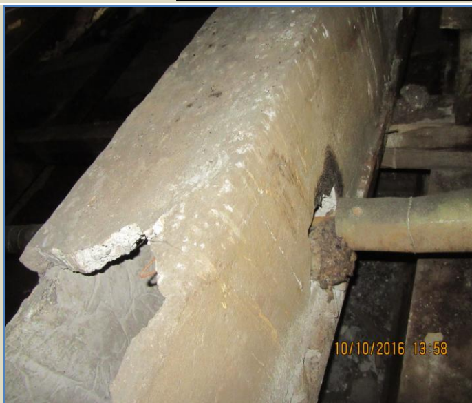
17.att.Demontējamie komunikācijas kanāli.
