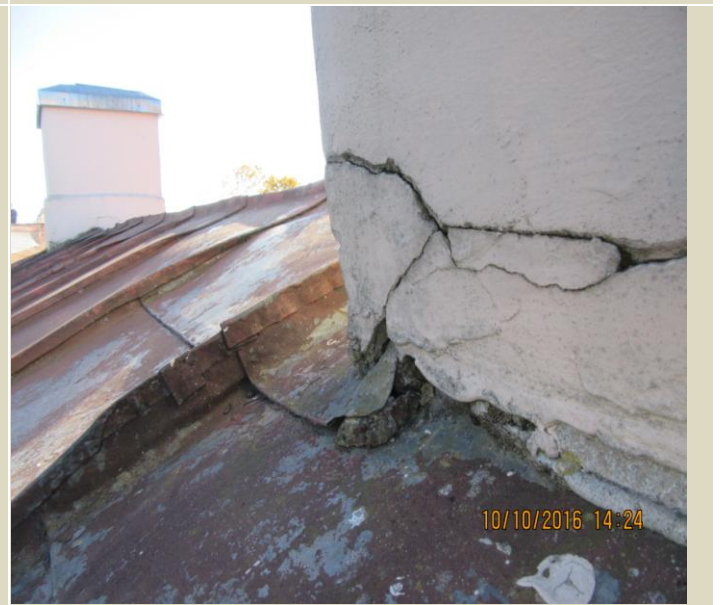
66.att.Dūmkanāla salaidums ar jumta segumu.
