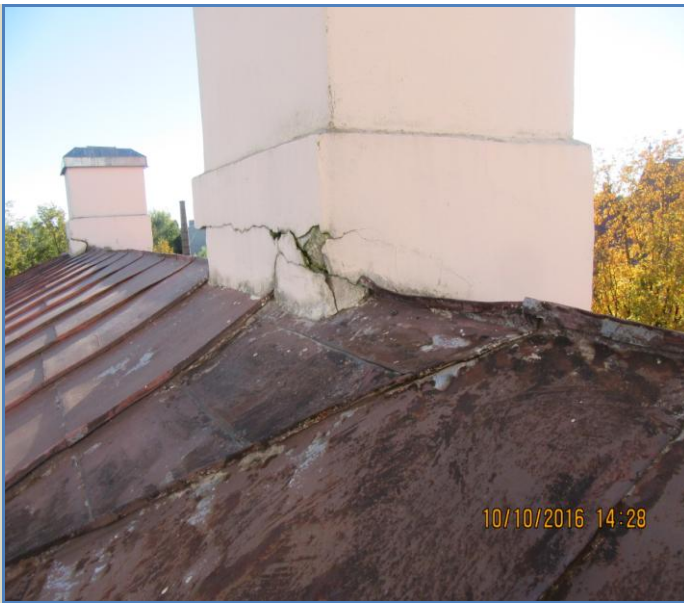
67.att. Dūmkanāla salaidums ar jumta segumu.
