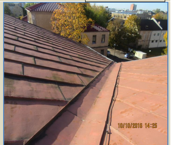
54.att. Jumta iekšējā satece
