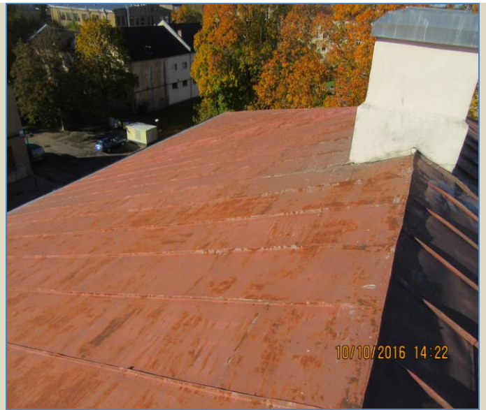
44.att.Jumta skārda segums
