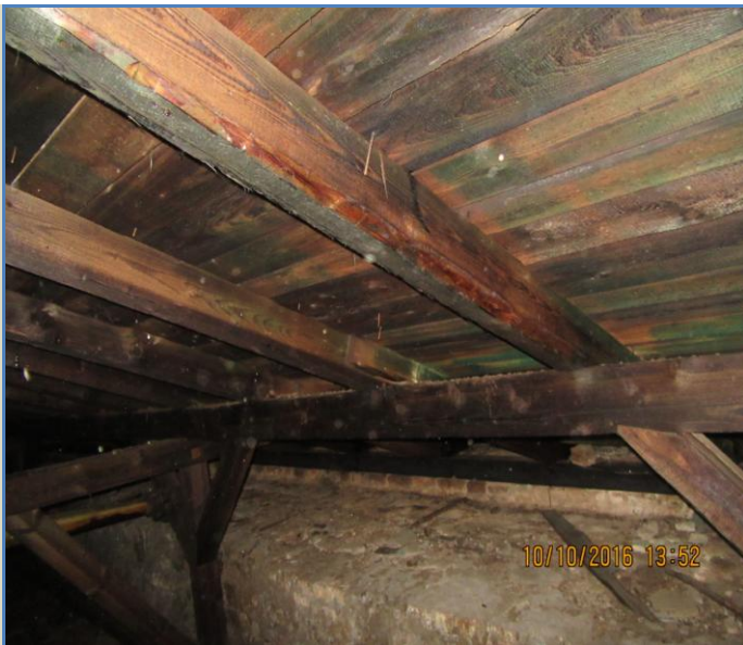
7.att. Bēniņu jumta konstrukcijas krēsls.
