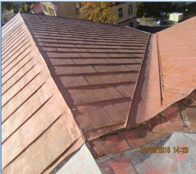
39.att. Jumta skārda segums
