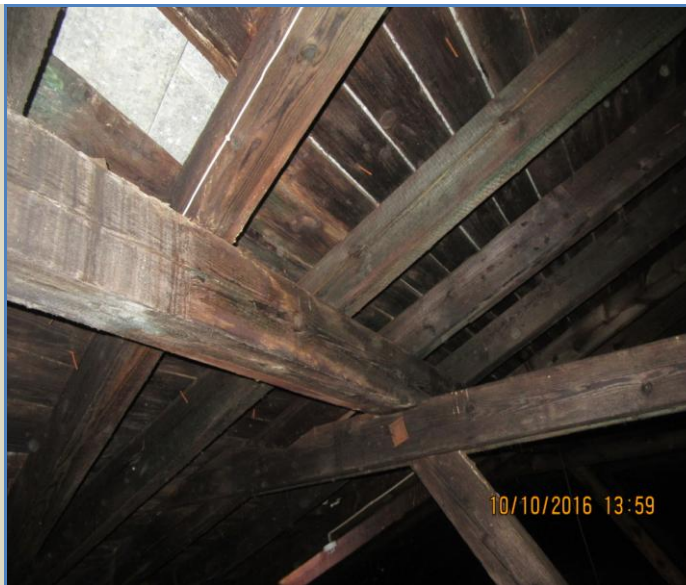
13.att.Jumta nesošās konstrukcijas krēsls.
