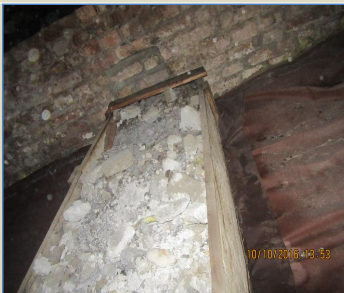
15.att.Demontējamie komunikācijas kanāli.
