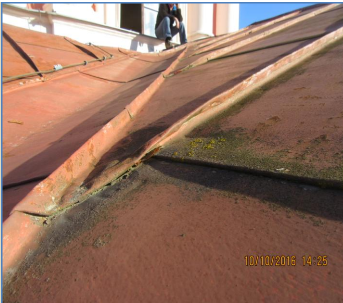
55.att.Jumta seguma iekšējā satece.
