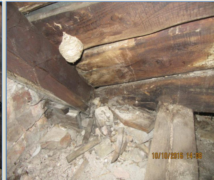
28.att. Jumta klāja trupe pie jumta dzegas.
