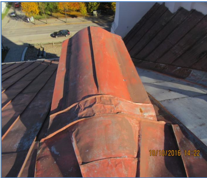
43.att.Jumta skārda segums.
