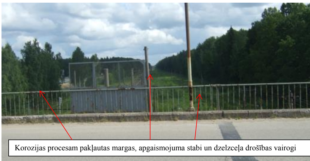
Att. 30 – Pārveda aprīkojuma bojājumi
