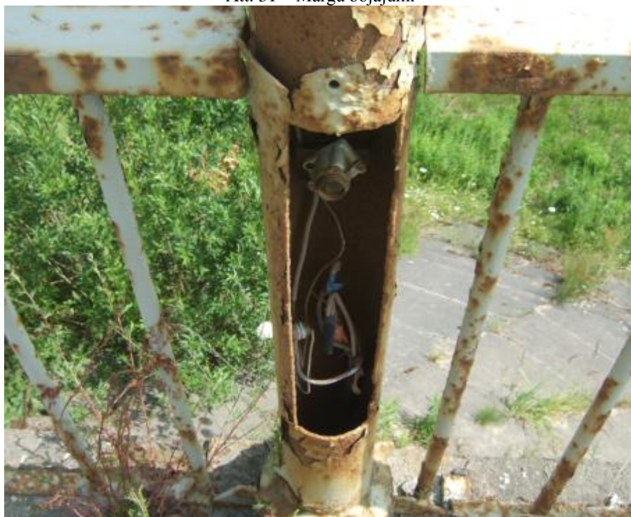
Att. 32 – Izdemolēta apgaismojuma sistēma
