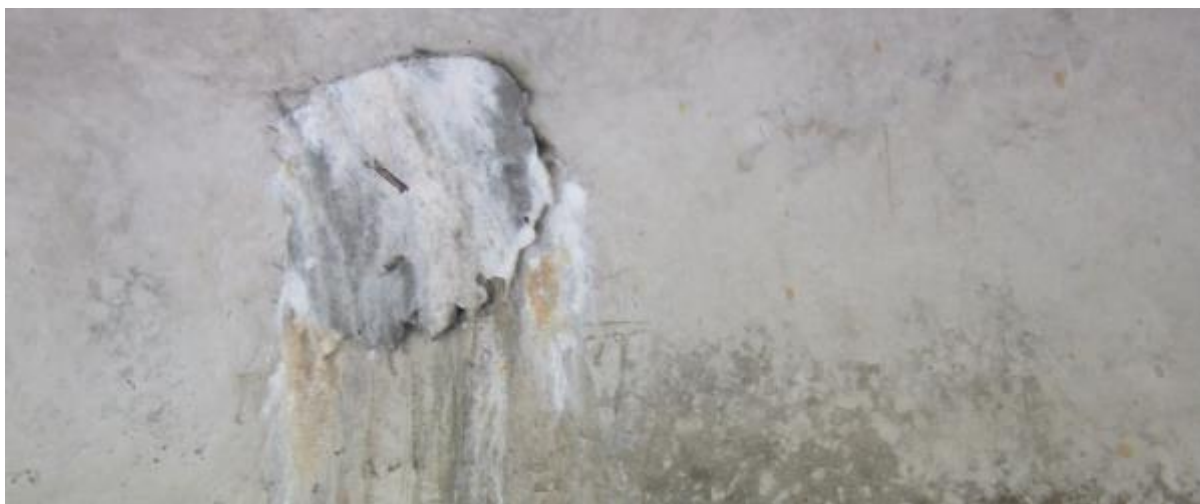
Att. 22 – Ķīmiskā izskalošanās montāžas lūkas apkaimē
