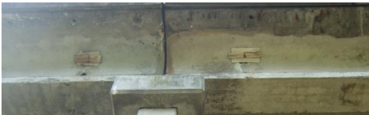
Att. 21 – Montāžas lūkas aizsegtas ar koka dēļiem
