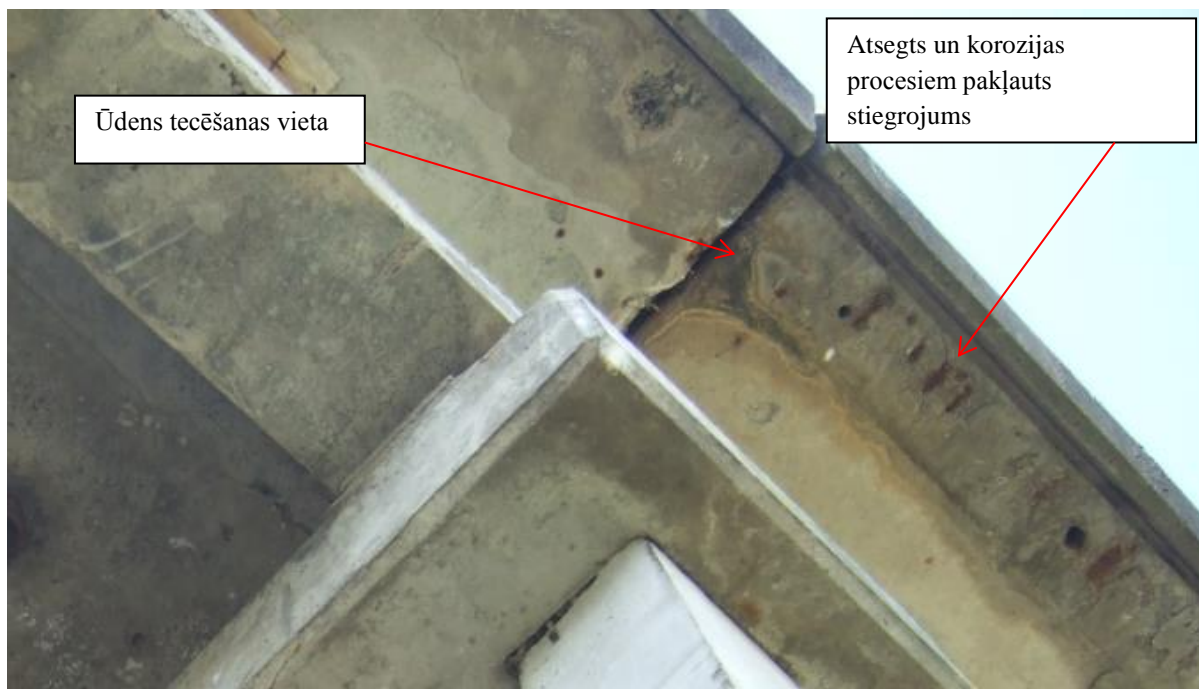
Att. 23 – Ūdens tecēšanas vietas uz malējām sijām
