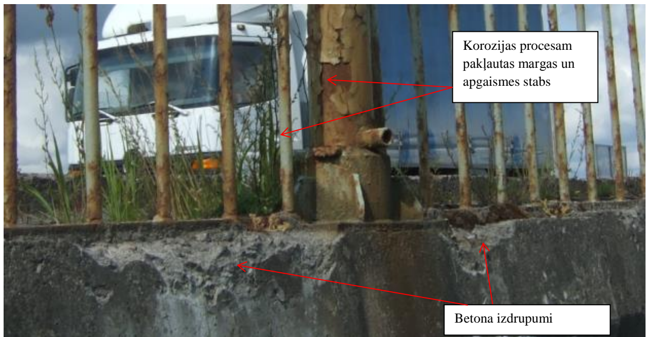
Att. 34 – Pārveda aprīkojuma bojājumi
