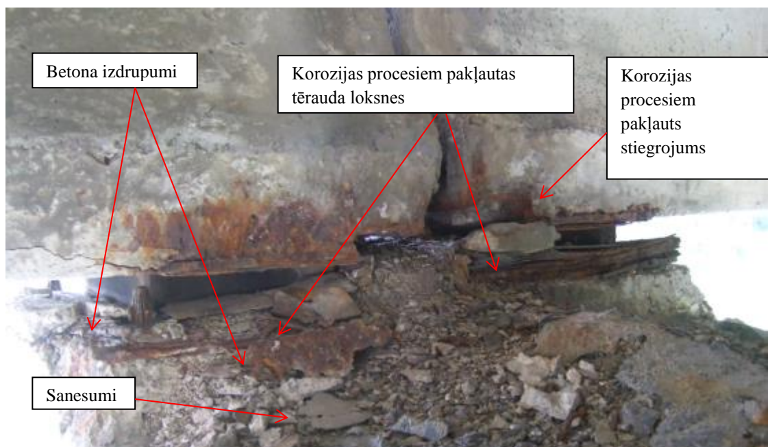
Att. 14 – Balstīklu postamentu bojājumi
