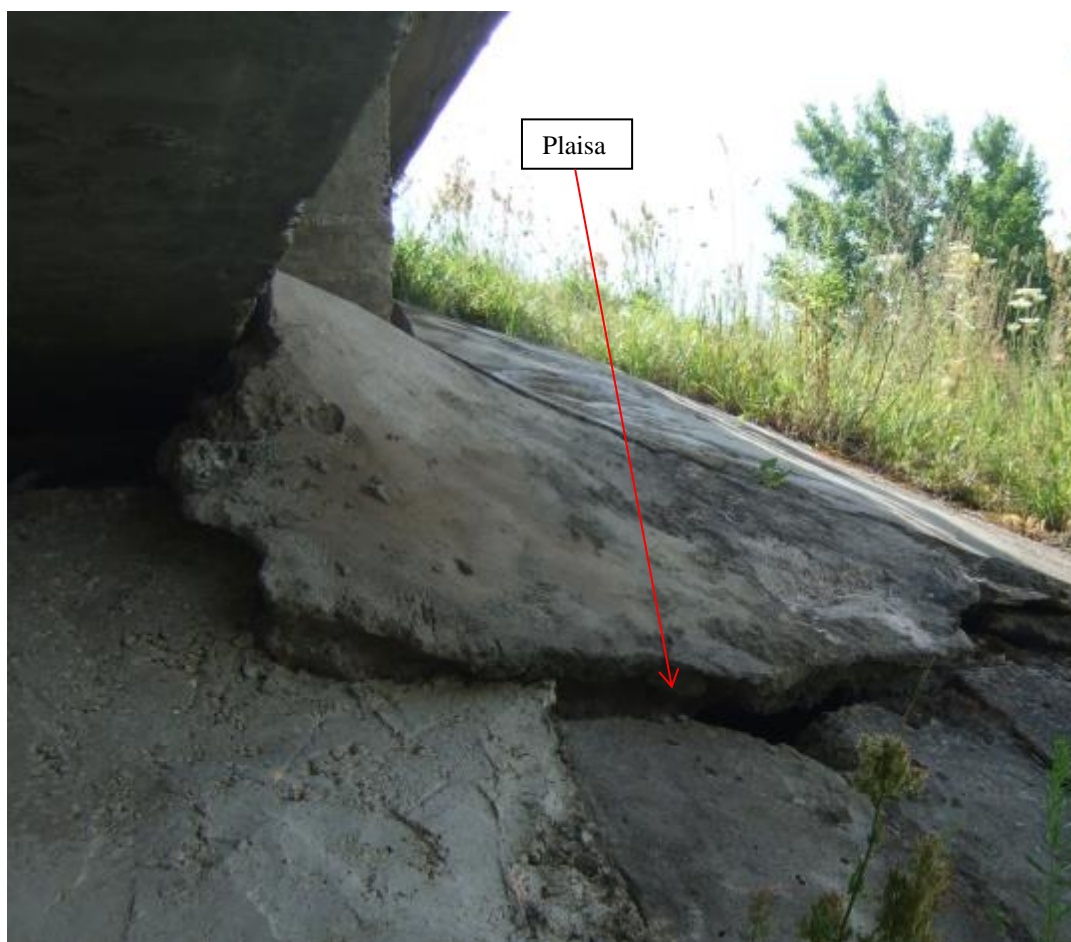
Att. 7 – Konusu nostiprinājumu bojājumi
