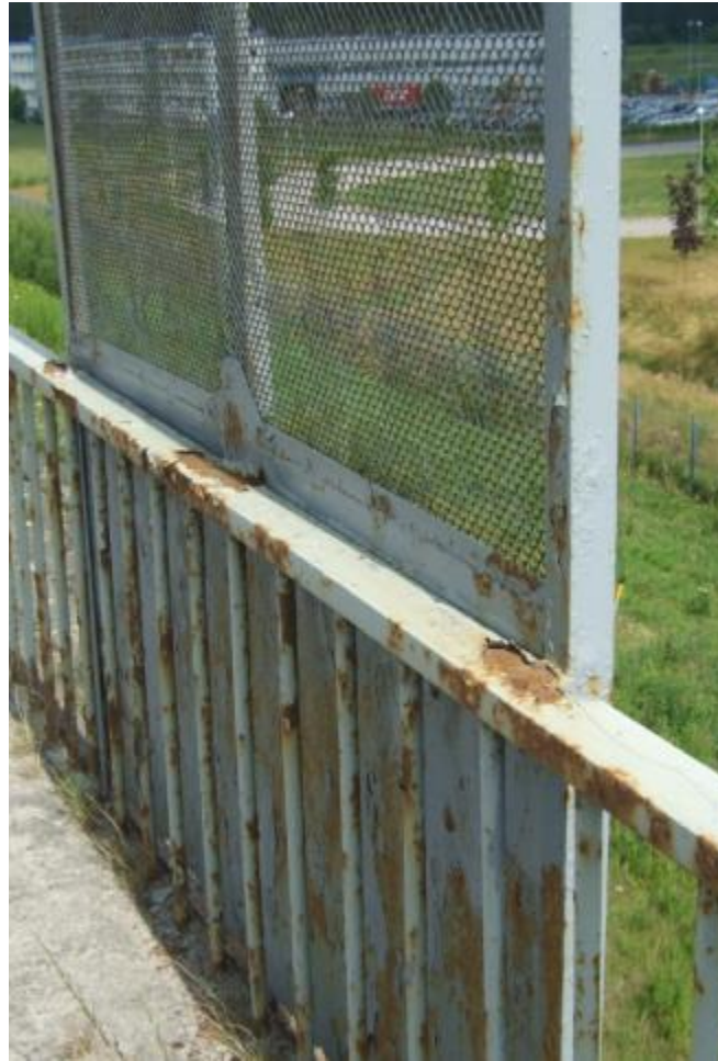
Att. 33 – Korodējis dzelzceļa aizsargvairogs
