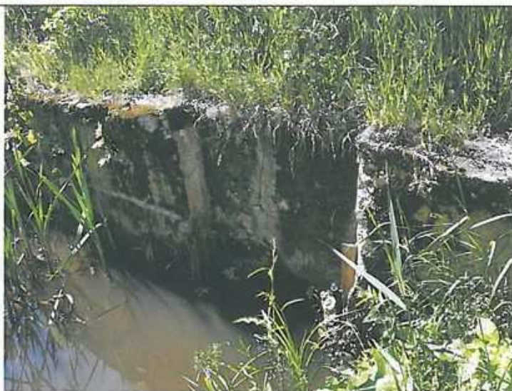
Att. 6 – Izplūdes daļas konstrukcijas saplaisājušas.
