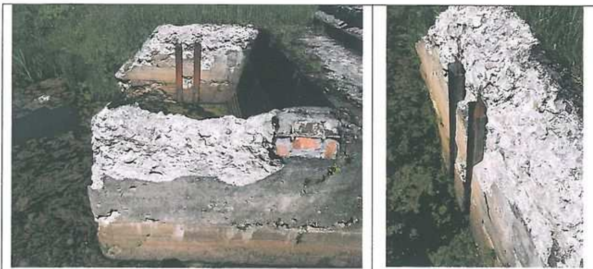
Att. 3 – Slūžu konstrukcijas stipri sadēdējušas un korodējušas.
