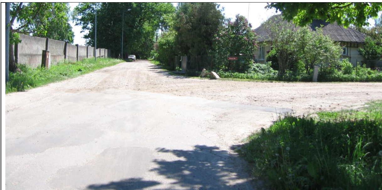
3.2.5. Pie krustojuma ar Birzes ielu asfaltbetona segums beidzas. Prioritāšu sistēma neskaidra. Tā kā priekšrocības zīmju nav, krustojumam ir viens asfaltēts galvenā ceļa zars un divi mazāksvarīgie zari ar grants segumu. Krustojumā pastāv redzamības ierobežojumi – žogs un krūmi.
