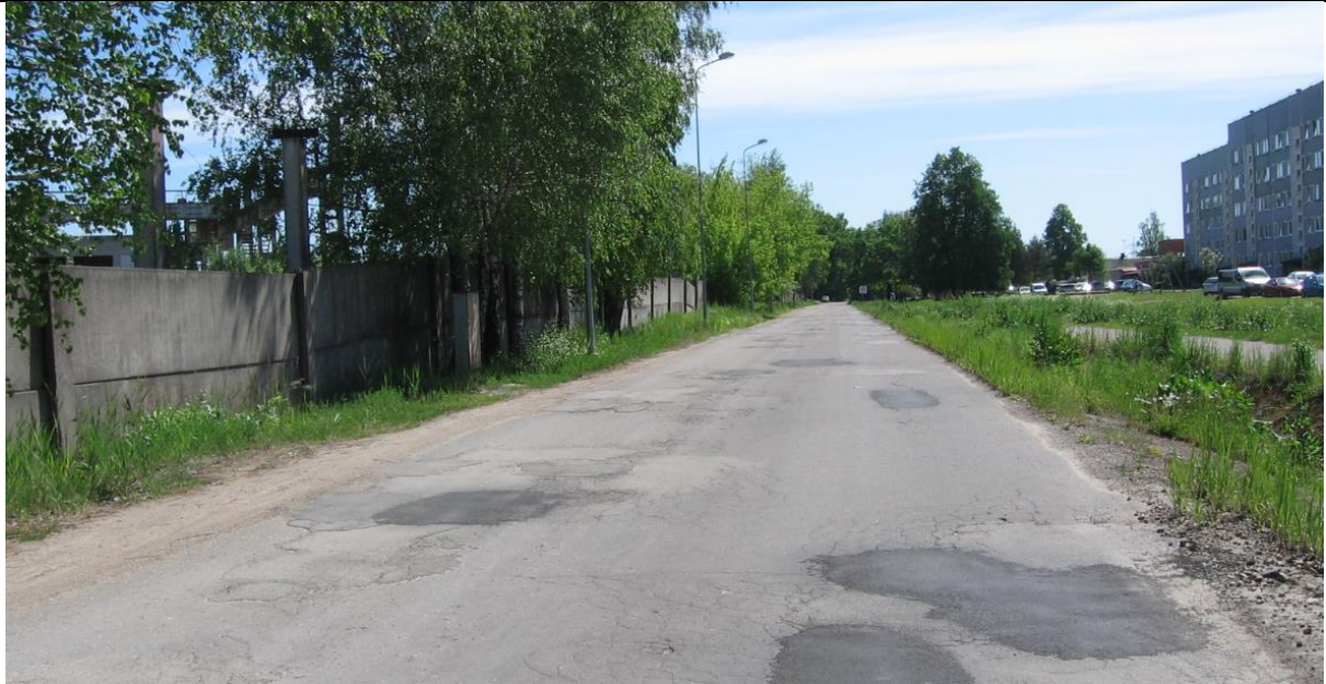
3.2.3. Brauktuve sliktā stāvoklī, ar plaisām un seguma remontu pēdām. Ielas kreisajā pusē salīdzinoši nesen veidots apgaismojums, bet tas izvietots ietvei pretējā ielas pusē, samazinot ietves apgaismojumu.
