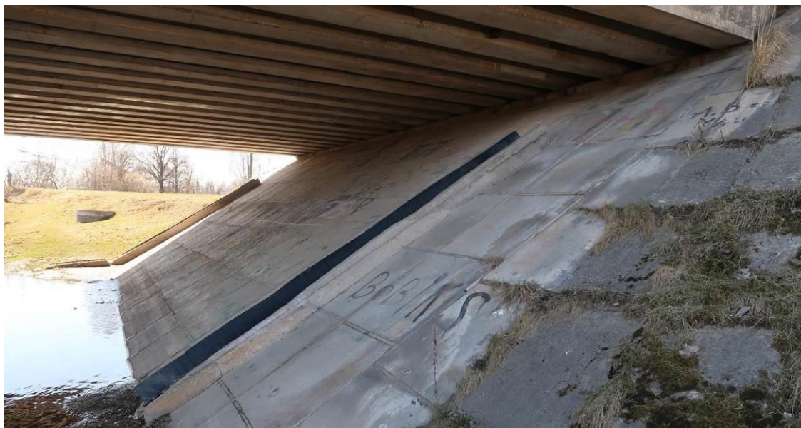
2.att. Krasta balsts Nr.1 un kreisā krasta konusa nostiprinājums.
