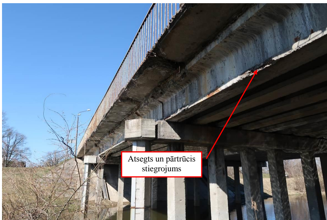
12.att. Skats uz laiduma konstrukcijas sijām no labā krasta augštecē.
