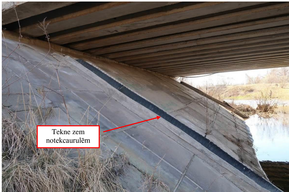
4.att. Krasta balsts Nr.4 un labā krasta konusa nostiprinājums.
