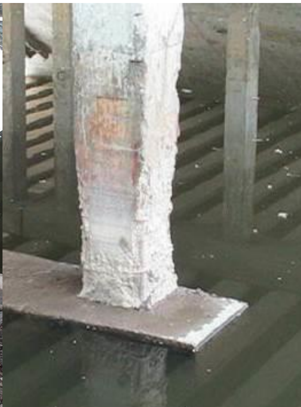
9.att. Sairis betons stata/pāļa lejas daļā.
