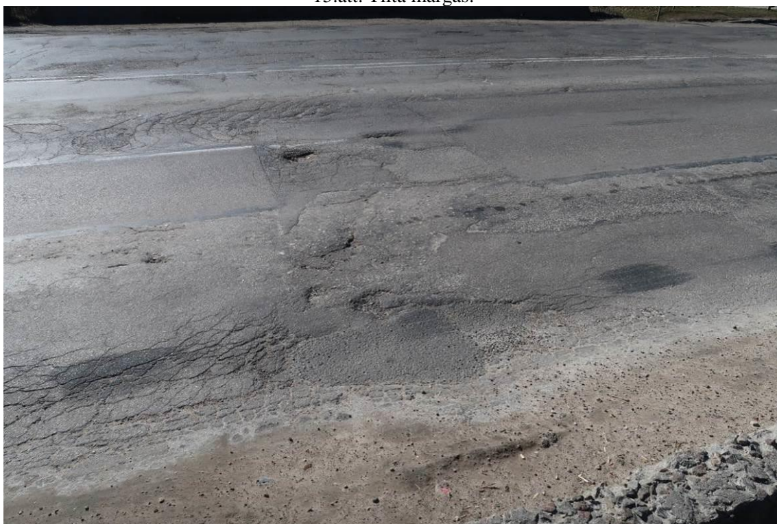
16.att. Brauktuves asfaltbetona sega uz tilta.
