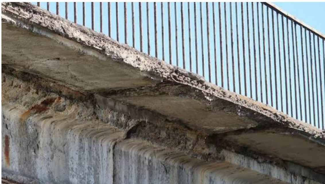
13.att. Skats uz ietves blokiem no tilta apakšas.
