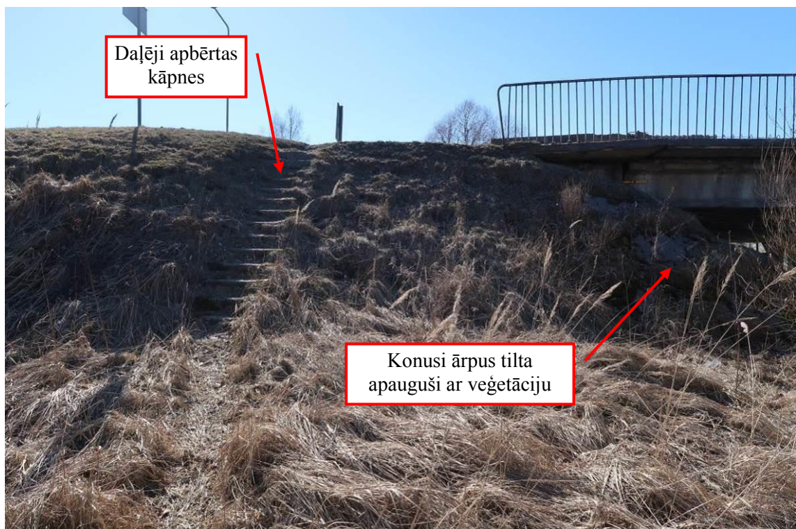
5.att. Konusa nostiprinājums pie balsta Nr.4, skats no lejtecē.
