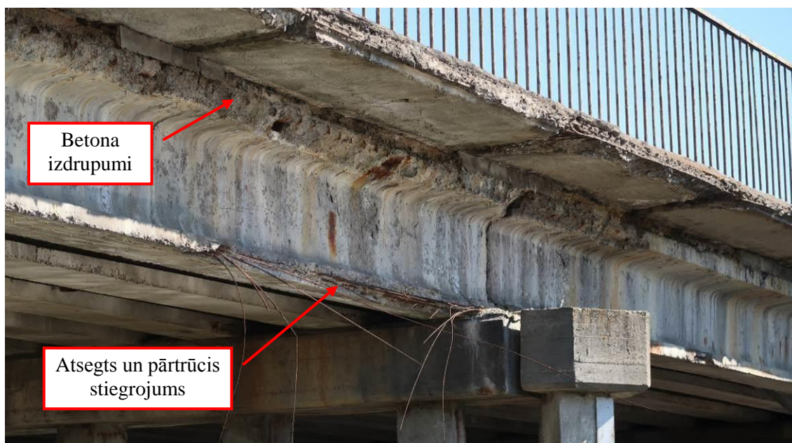
11.att. 1. un 2. Laiduma 1.sijas virs balsta Nr.2.
