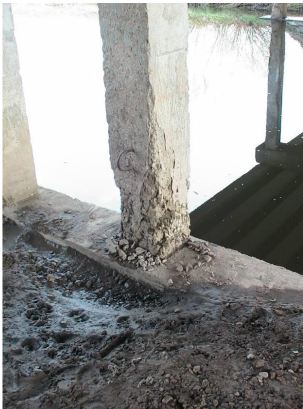
8.att. Sairis betons stata/pāļa lejas daļā.
