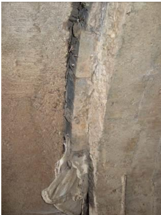
24.att. Caurtekas Nr.1 sekciju savienojuma vietas bojājumi
