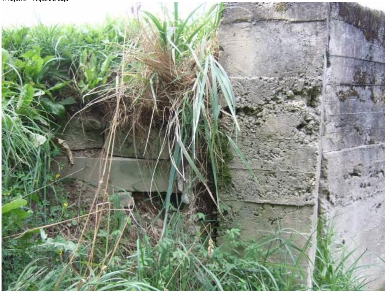
14.att. Grunts izskalojums pie izteces puses gala sienas
