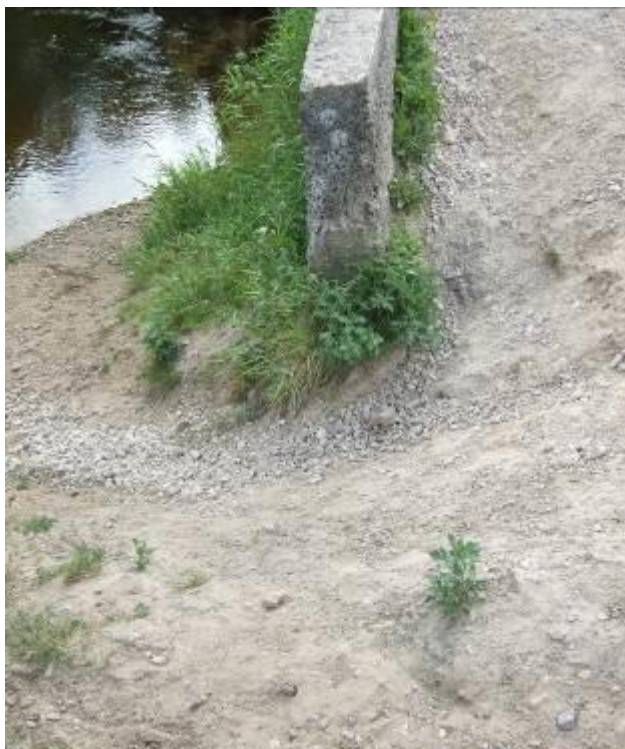
15.att. Caurtekas izteces puses gala sienas defekti
