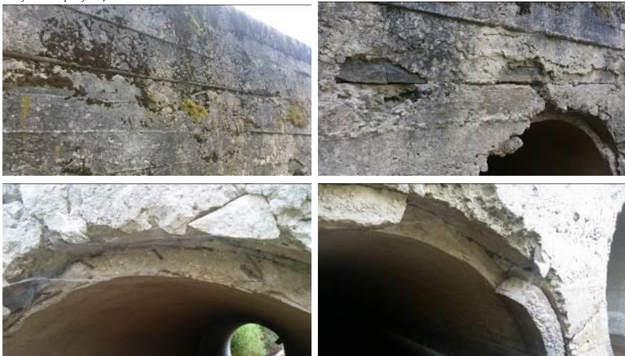
16.att. Izteces puses gala sienas un caurtekas sekciju defekti
