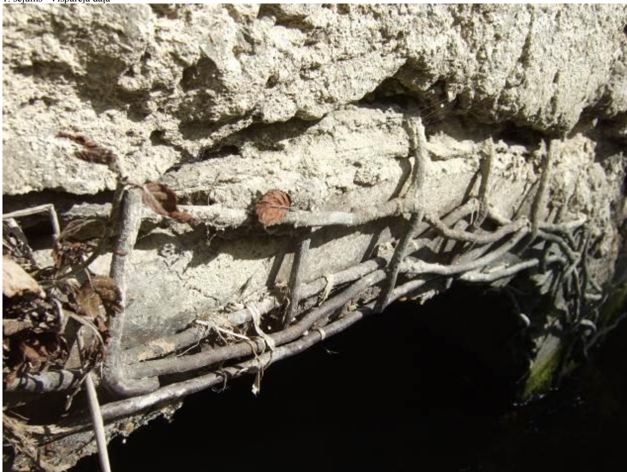
9.att. Ieteces puses vidus caurtekas sekcijas defekti
