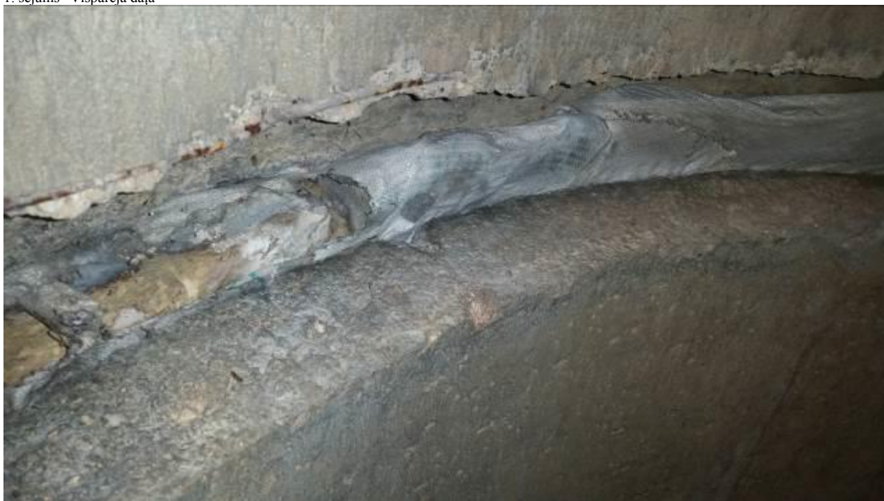
19.att. Caurtekas Nr.3 sekciju savienojuma vietas bojājumi
