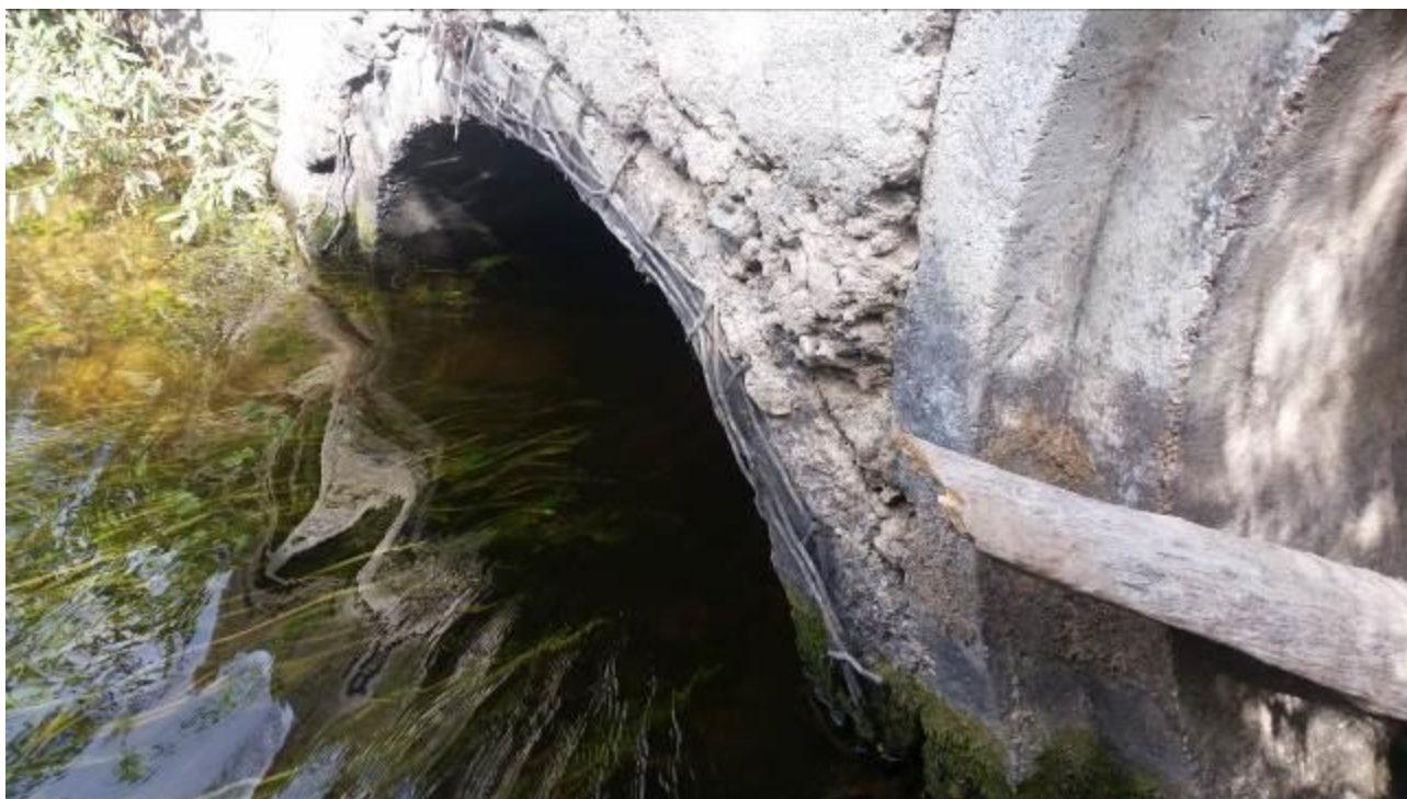
8.att. Ieteces puses gala sienas un vidus caurtekas sekcijas defekti
