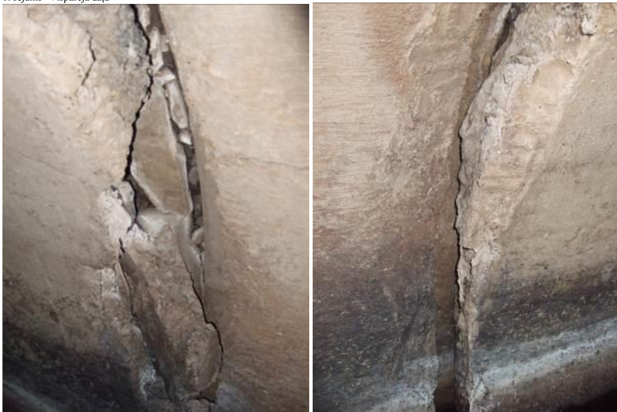
23.att. Caurtekas Nr.2 sekciju savienojuma vietas bojājumi
