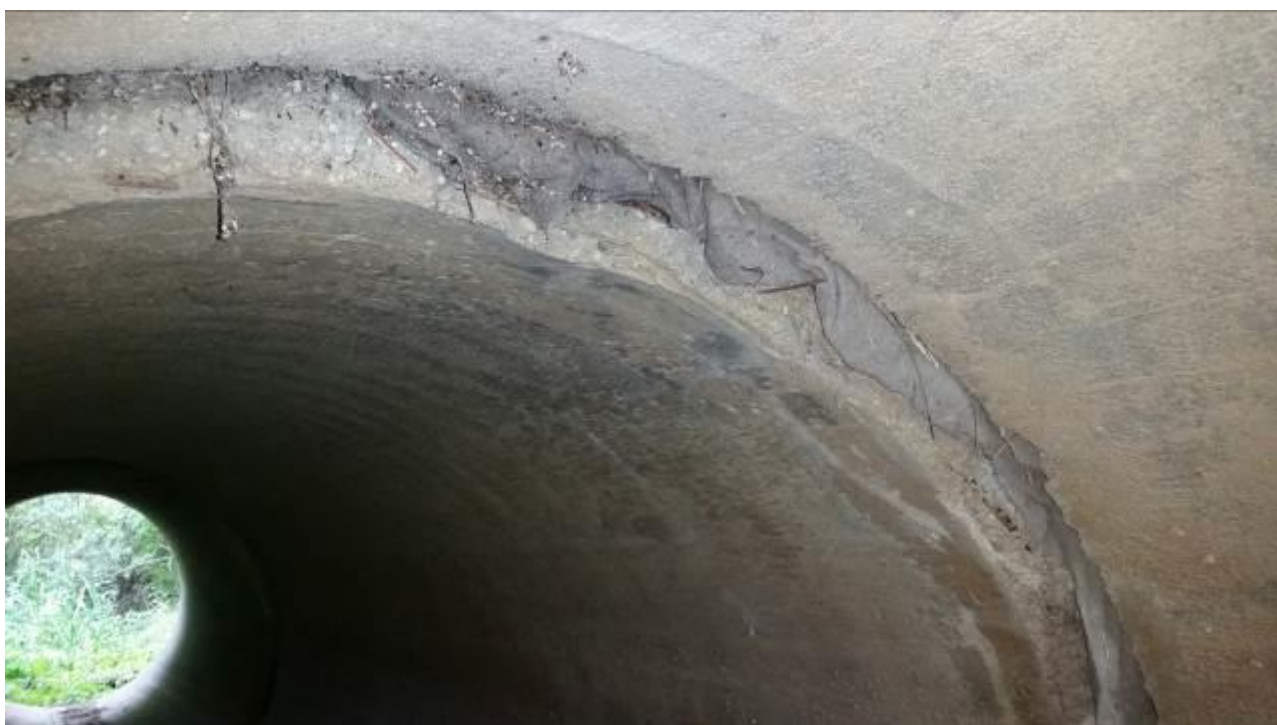
38.att. Caurtekas sekciju savienojuma vietas. Šuvju bojājumi
