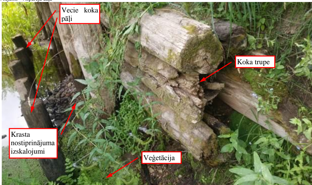
7.att. Krasta nostiprinājuma bojājumi pie balsta Nr. 1
