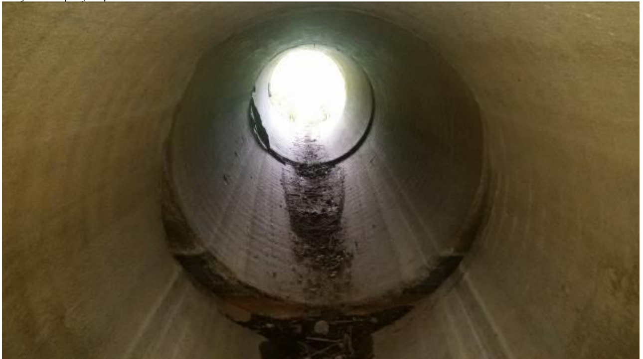
39.att. Skats caurtekas iekšpusē. Caurtekas sekciju nobīde
