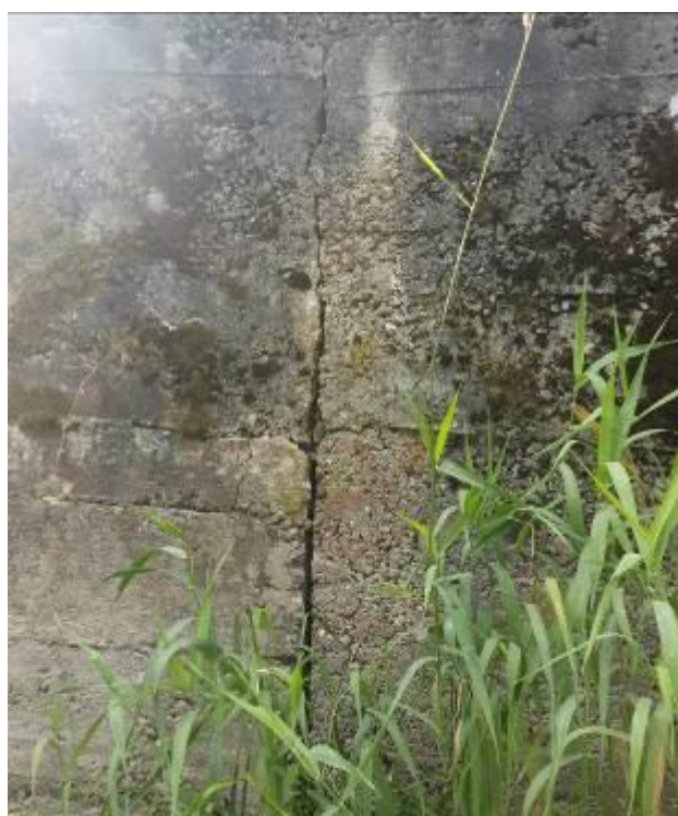
15.att. Caurtekas izteces puses gala sienas defekti
