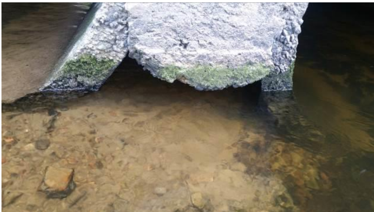
17.att. Upes gultnes izskalojums un gala sienas sadēdēšana izteces galā
