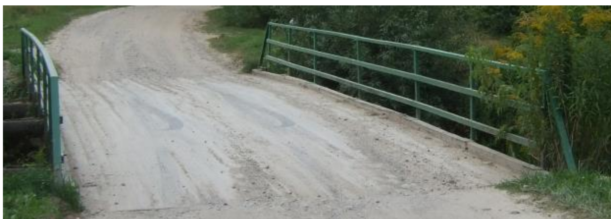
18. att. Brauktuves konstrukcijas iesēdums
