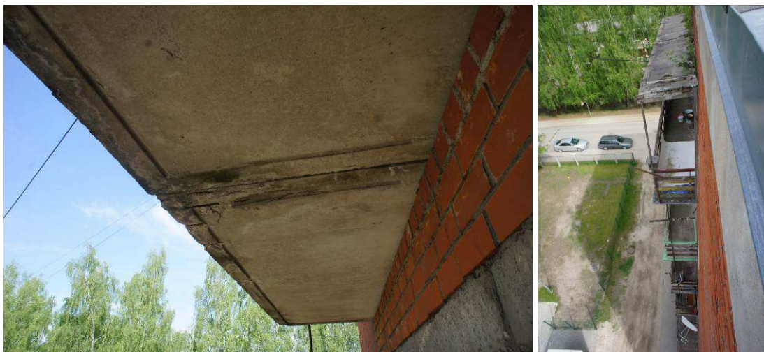
17. att. Balkona konstrukcija
