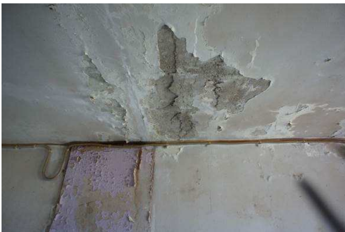
Foto attēls Nr. 18 Elektroinstalācija
