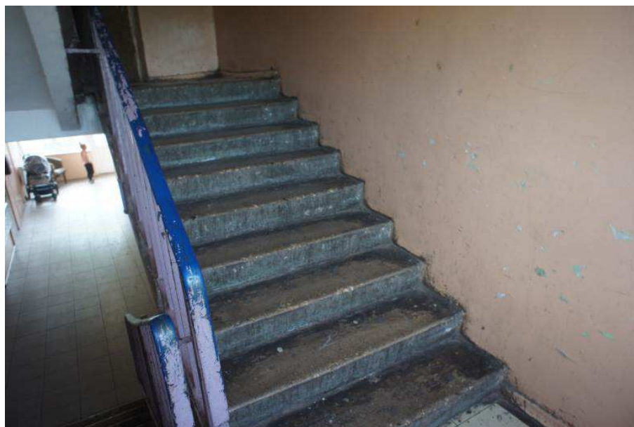
19. att. Dzelzsbetona kāpnes iekštelpās
