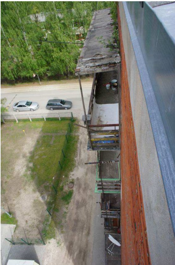
Foto attēls Nr.41 Balkoni
