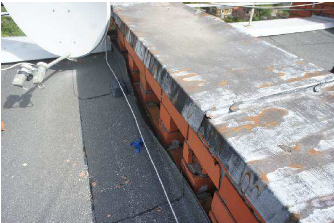
Foto attēls Nr. 37 Ventilācijas skurstenis
