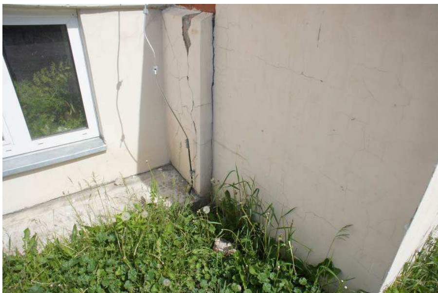
3. att. Ēkas betonētā aizsargapmale
