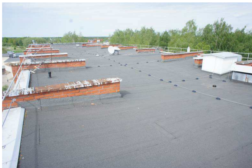
9. att. Jumta virsskats
