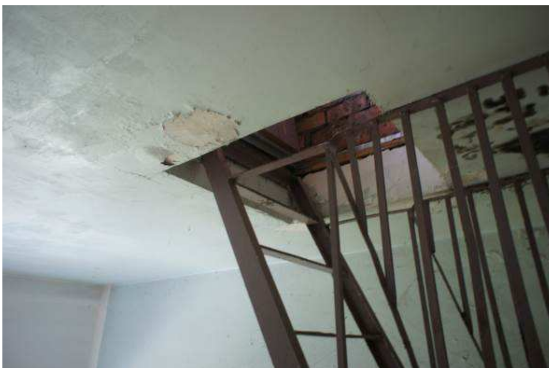
Foto attēls Nr. 34 Metāla kāpnes uz jumtu
