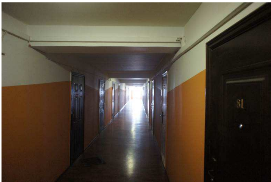
8. att. Ēkas gaitenis ar dzelzsbetona sijām
