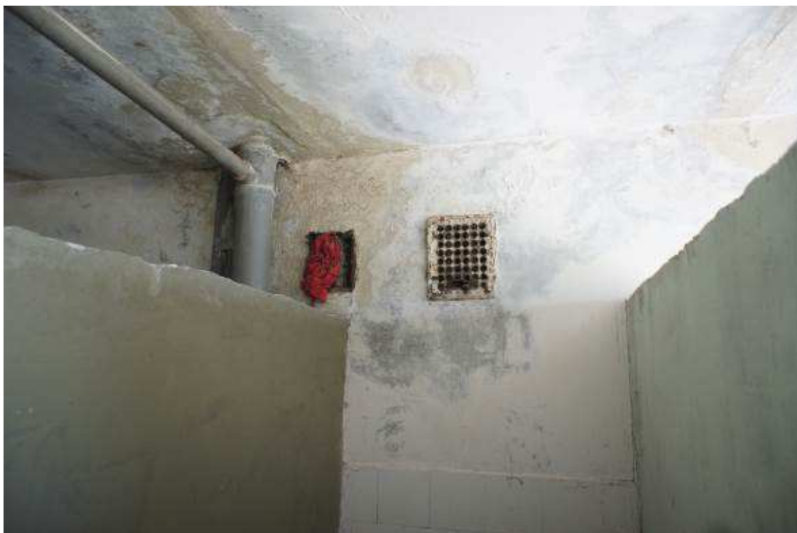
Foto attēls Nr. 25 Mitruma radītais bojājums sienās
