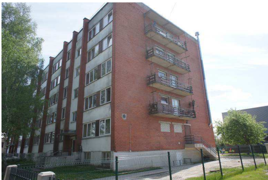
16. att. Balkonu konstrukcijas uz rietumu fasādes
