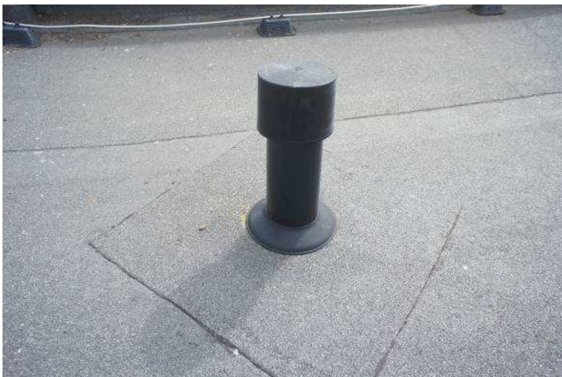
Foto attēls Nr. 38 Jumta ventilācijas skurstenis
