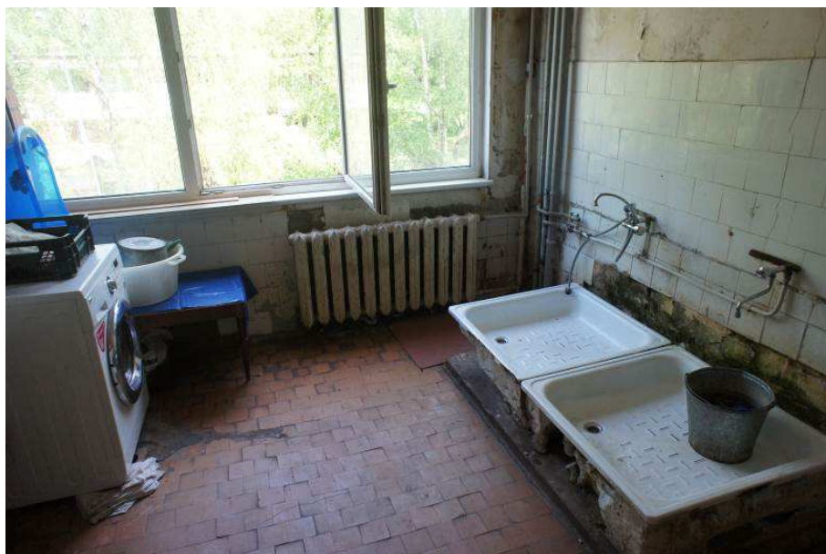
25. att. Sanitāro telpu grīda
