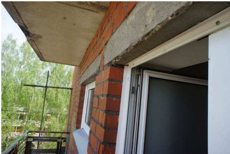
7. att. Dzelzsbetona ailu pārsedze
