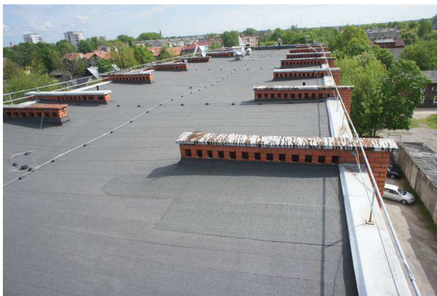
14. att. Jumta virsskats
