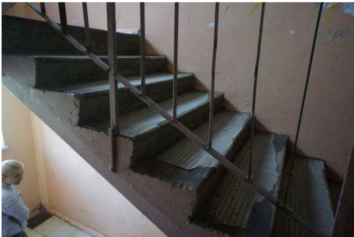
Foto attēls Nr. 31 Dzelzsbetona kāpnes
