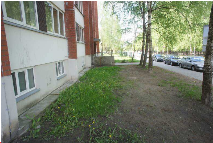
2. att. Ēkas cokols no ēkas ārpusē
