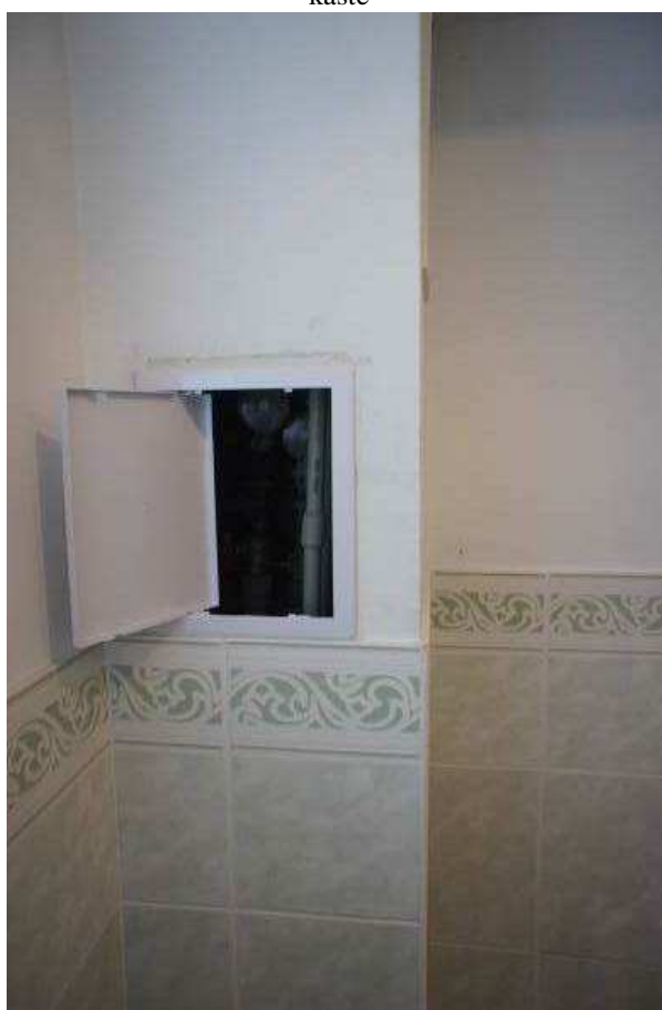
Foto attēls Nr. 12 Atvērums uz šahtu
