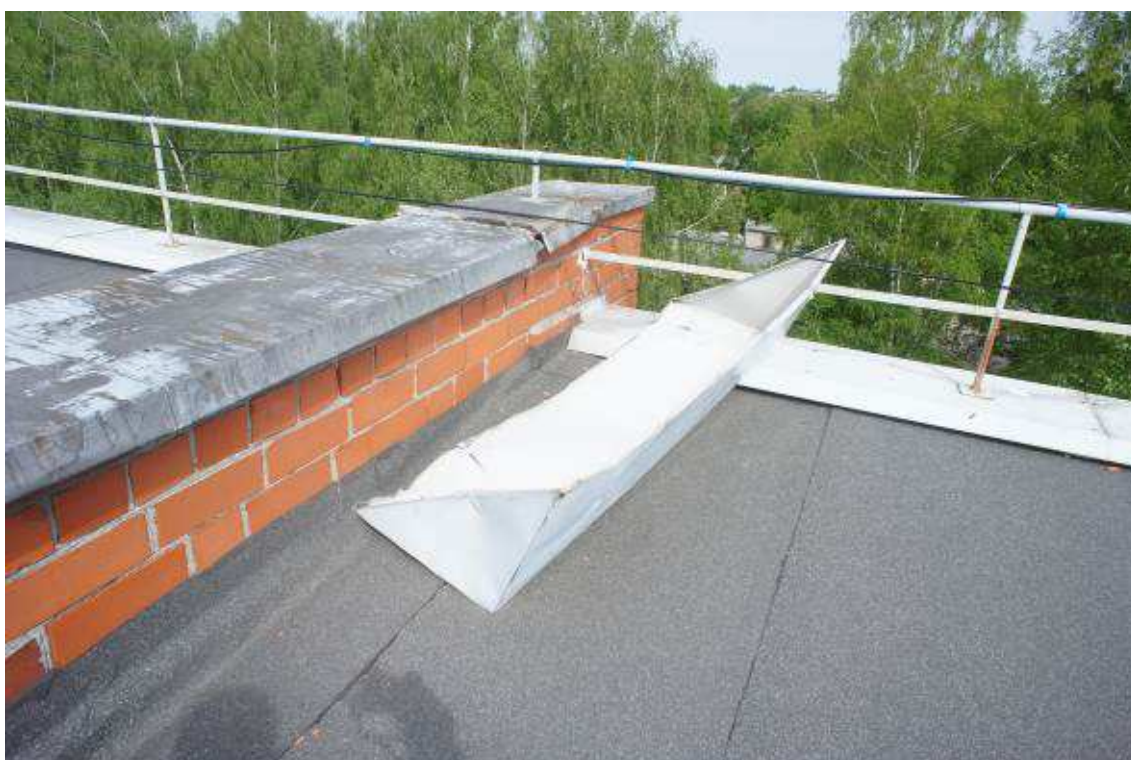
Foto attēls Nr. 40 Ventilācijas skurstenis
