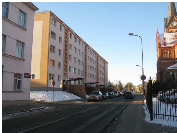
29. attēls. Piecstāvu dzīvojamā apbūve Rāiņa ielā
