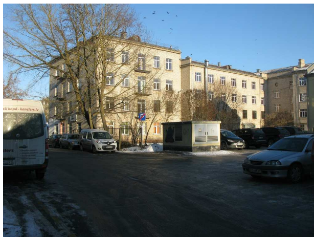
31. attēls. Četrstāvu dzīvojamā apbūve Driksas ielā
