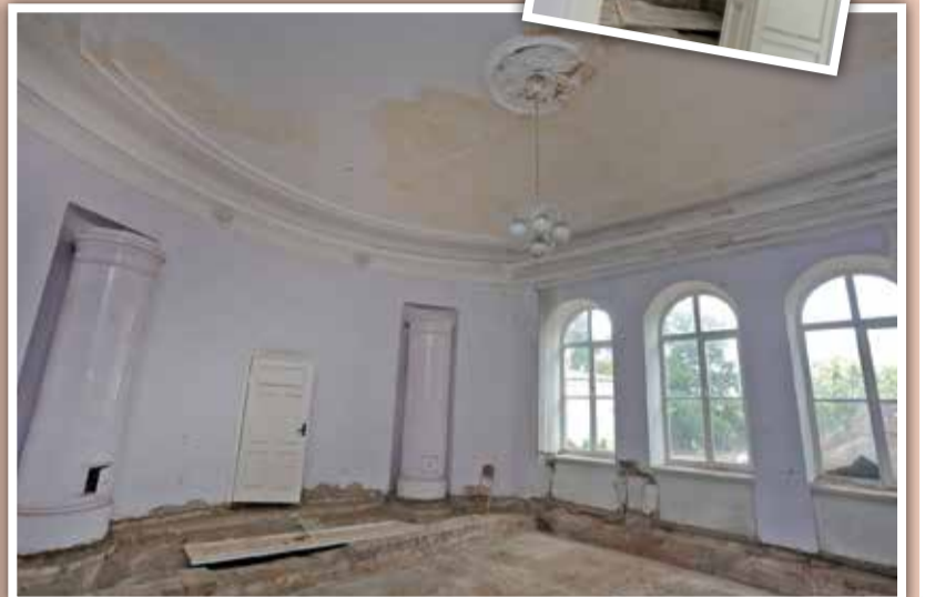
Greznākā telpa ēkā ir svinību zāle, kurā tiks atjaunoti arhitektoniski vērtīgie elementi – podiņu krāsnis, griestu dekoru un durvju aila. «Šīs durvis nav autentiskas – par to liecina tas, ka nesakrīt aillas un durvju pildīņu izvietojums. Ailu atjaunosim, bet durvis izgatavosim jaunas,» norāda SIA «Torensberg» darbu vadītāja palīgs Edgars Ramanis.
