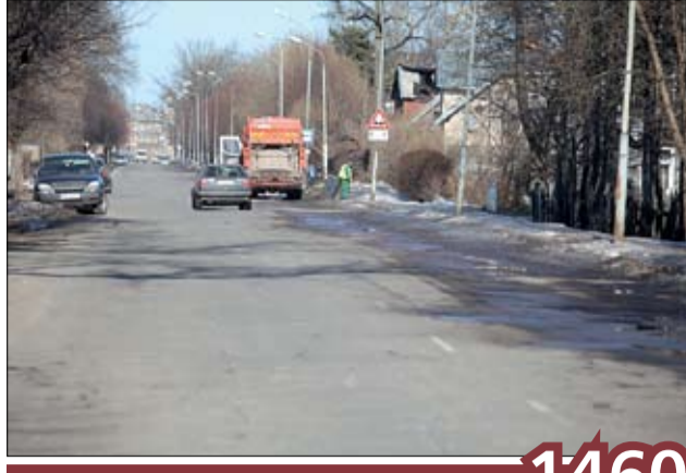
Jaunu asfalta uzlies trīs ielu posmos 1460 metru kopgarumā, tostarp Dambja ielā posmā no Aspazijas līdz Atmodas ielai.
