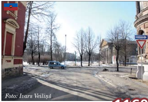
No jauna izbūvēs četrus ielu posmus 1160 metru kopgarumā, tostarp 160 metrus garo Sporta ielas turpinājumu.
