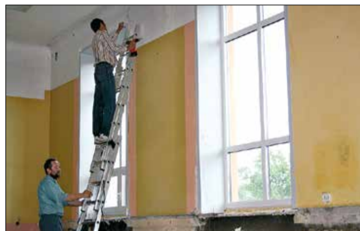
Spīdolas ģimnāzijā remontu piedzīvos trīs telpas – fizikas, matemātikas kabinets, kā arī konferenču zāle, kurā norit vēstures un politikas apgūšana. «Ja būtu vairāk līdzekļu, izglītības iestādē remontētu visu pēc kārtas,» bilst skolas direktore Ilze Vilkārse.
