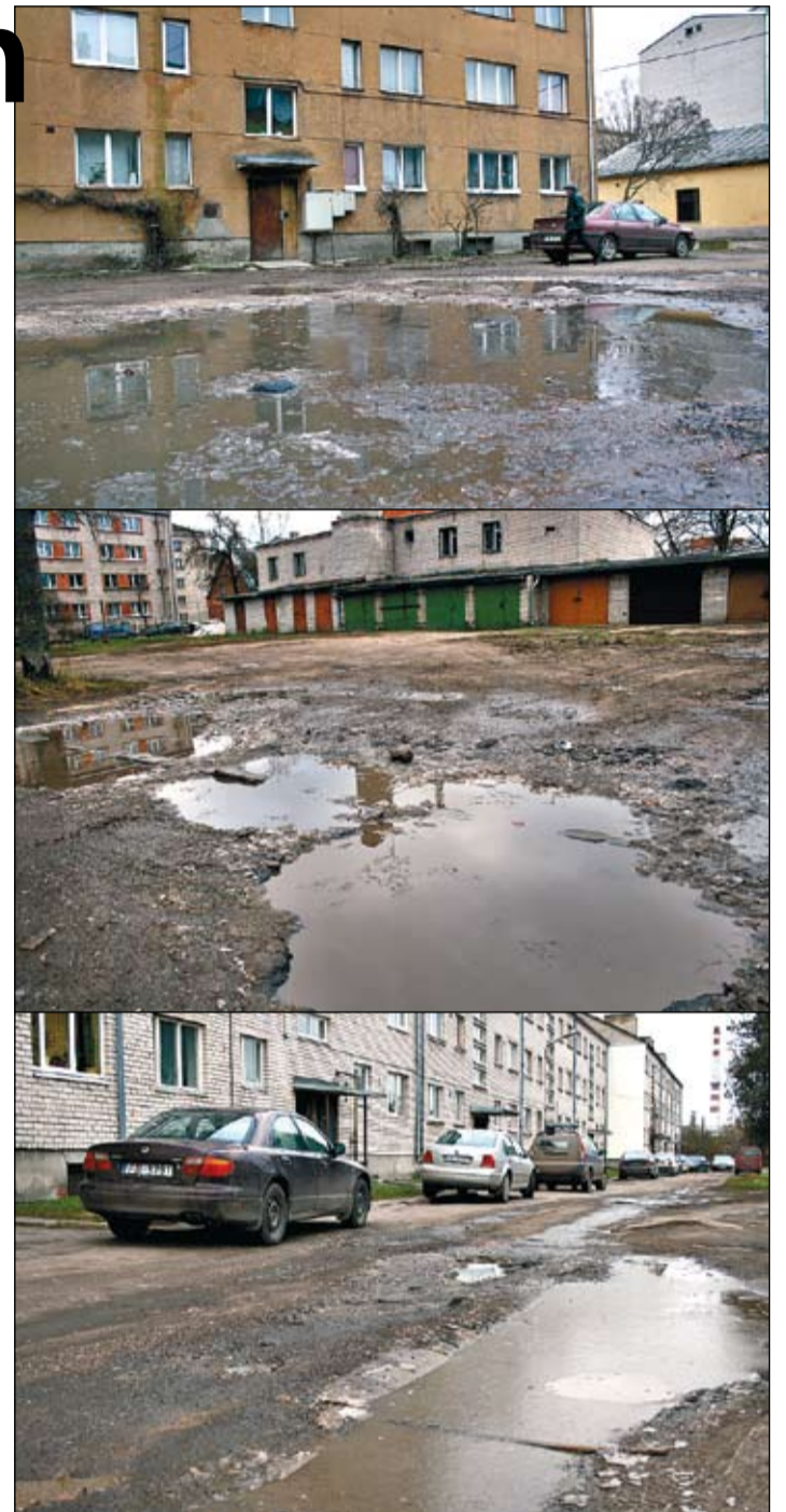
Māju, kuras apsaimnieko Jelgavas Nekustamā īpašuma pārvalde, pagalmi un ceļi savu laiku jau nokalpojuši – speciālisti norāda, ka asfalta ekspluatācijas termiņš ir vidēji desmit gadu, taču lielākoties tas uzklāts vairāk nekā pirms piecpadsmit gadiem. Tas, kad konkrēta nama pagalmā tiks labiekārtots, atkarīgs no pašiem dzīvokļu īpašniekiem. Foto: JV
