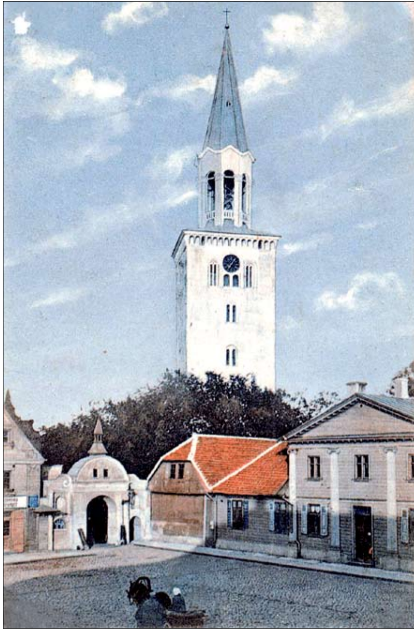
Šādi Svētās Trīsvienības baznīcas tornis izskatījās vēl 20. gadsimta pirmajā pusē, līdz to skāra pasaules kara postaža. Pēc tam, kad torni pagarināja, tas sasniedza 244 pēdas jeb 74,37 metrus un bija augstākā ēka pirmskara Jelgavā.
