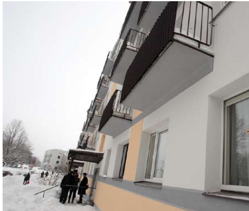
Balkonam jābūt drošam un norobežotam, un tas arī Raiņa ielas 3. mājas renovācijas procesā nodrošināts, turklāt, nākot pretim iedzīvotājiem, saskaņā ar projektu balkonu priekšējā mala ir slēgta. Jāpiebilst arī, ka tādējādi panākts vienots vizuālais skats visai mājai.
