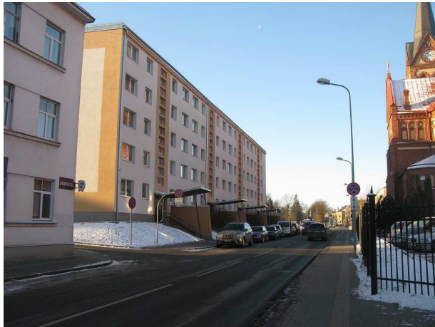
29. attēls. Piecstāvu dzīvojamā apbūve Rāiņa ielā
