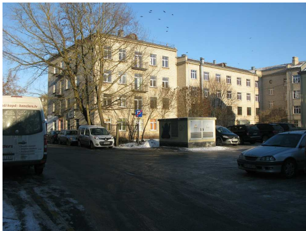
31. attēls. Četrstāvu dzīvojamā apbūve Driksas ielā
