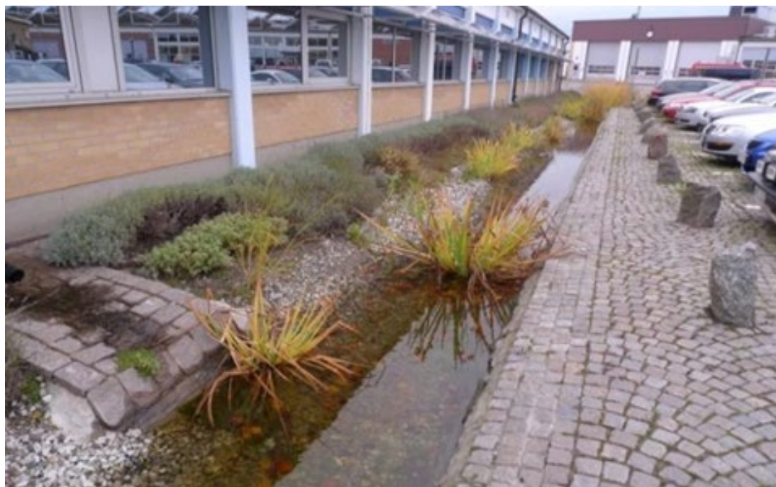
18.attēls. “Zaļo” risinājumu piemērs – bioievalka. Avots: Ilgtspējīga lietus ūdeņu apsaimniekošana. Rokasgrāmata “(D)rain for Life, projekta numurs EU41702
