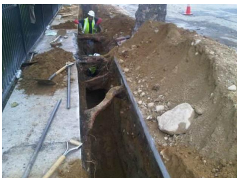
Att.Nr.4. Koku sakņu šurfēšana izmantojot „gaisa lāpstu” metodi („airspade”)
