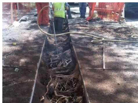
Att.Nr.4. Koku sakņu šurfēšana izmantojot „gaisa lāpstu” metodi („airspade”) (Avots: G. Leiburgs)
