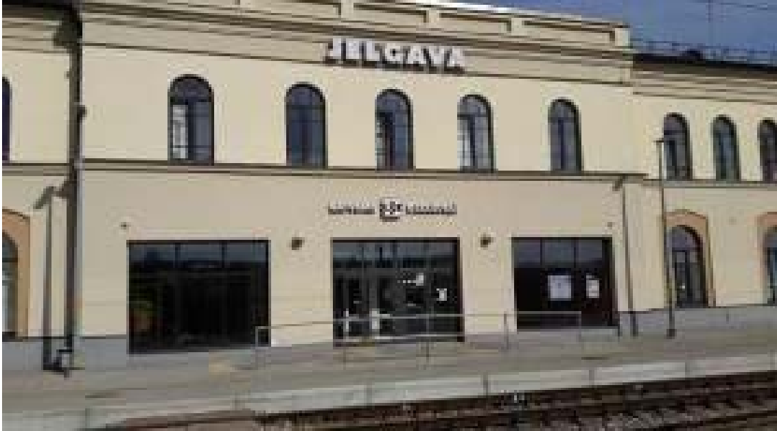
8.attēls. 1889.gadā uzceltās Otrajā pasaules karā izpostītās 1945. un 1962.gadā rekonstruētās un 2003.gadā kapitāli izremontētās Jelgavas dzelzceļa stacijas ēkas pašreizējais veidols.
