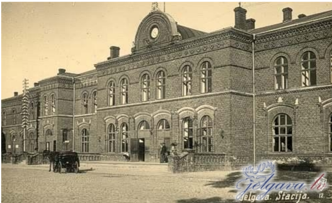
7.attēls. 1889.gadā uzceltā Jelgavas dzelzceļa stacijas ēka.
