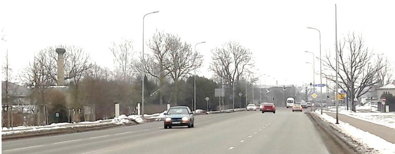
3.13.9. attēls. 4. skatu zona. Skats pa Dobeles šoseju uz nosacīto Atmodas ielas krustojumu centra virzienā
